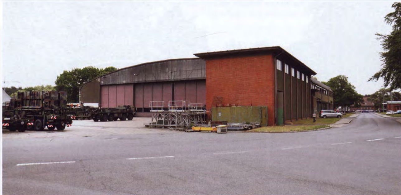
630 Wunstorf: Die Vorderseite der ehemaligen Werfthalle (heute Instandsetzungshalle). Es handelt sich hier um eine Werfthalle der ersten Generation mit Bogenbinderdach. Die Fenster in der Frontseite im ersten Stock wurden in der Nachkriegszeit zugemauert. Die Halle vor der Südecke der Werft wurde erst in der Zeit des Kalten Krieges errichtet.
