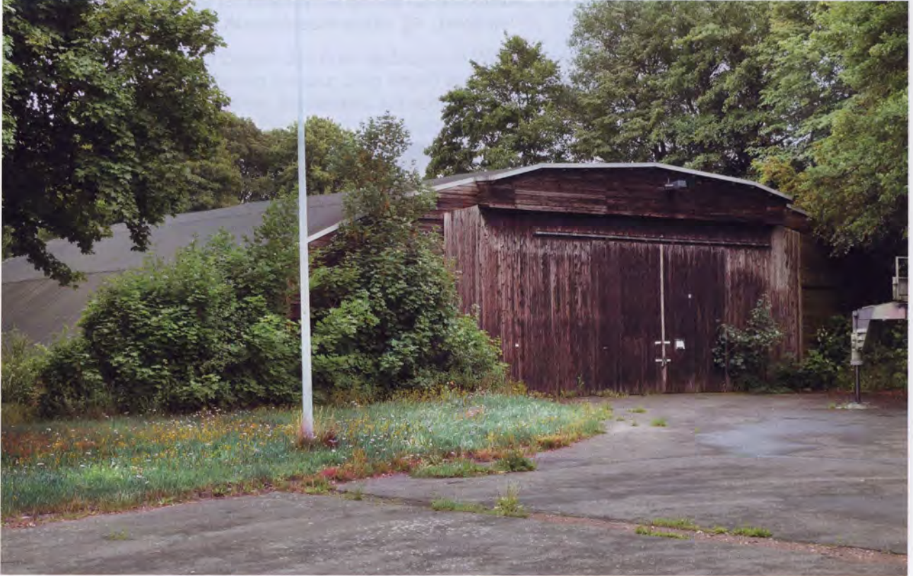
632 Wunstorf: Bei dieser Wärmeschutzhalle wurden die Haltevorrichtungen für die Schiebetor und die Tore inzwischen durch andere Tore ersetzt.
