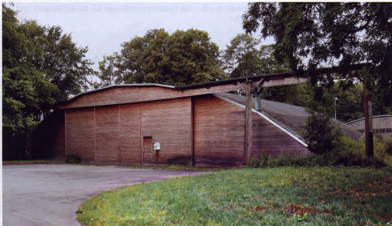
631 Wunstorf: Eine der fünf hölzernen Hallen im Abstellbereich Südwest nordwestlich von Kleinheidorn. Im Hintergrund die Rückseite einer zweiten Halle. Diese Halle ist noch im Originalzustand mit den ursprünglichen Schiebetoren.
